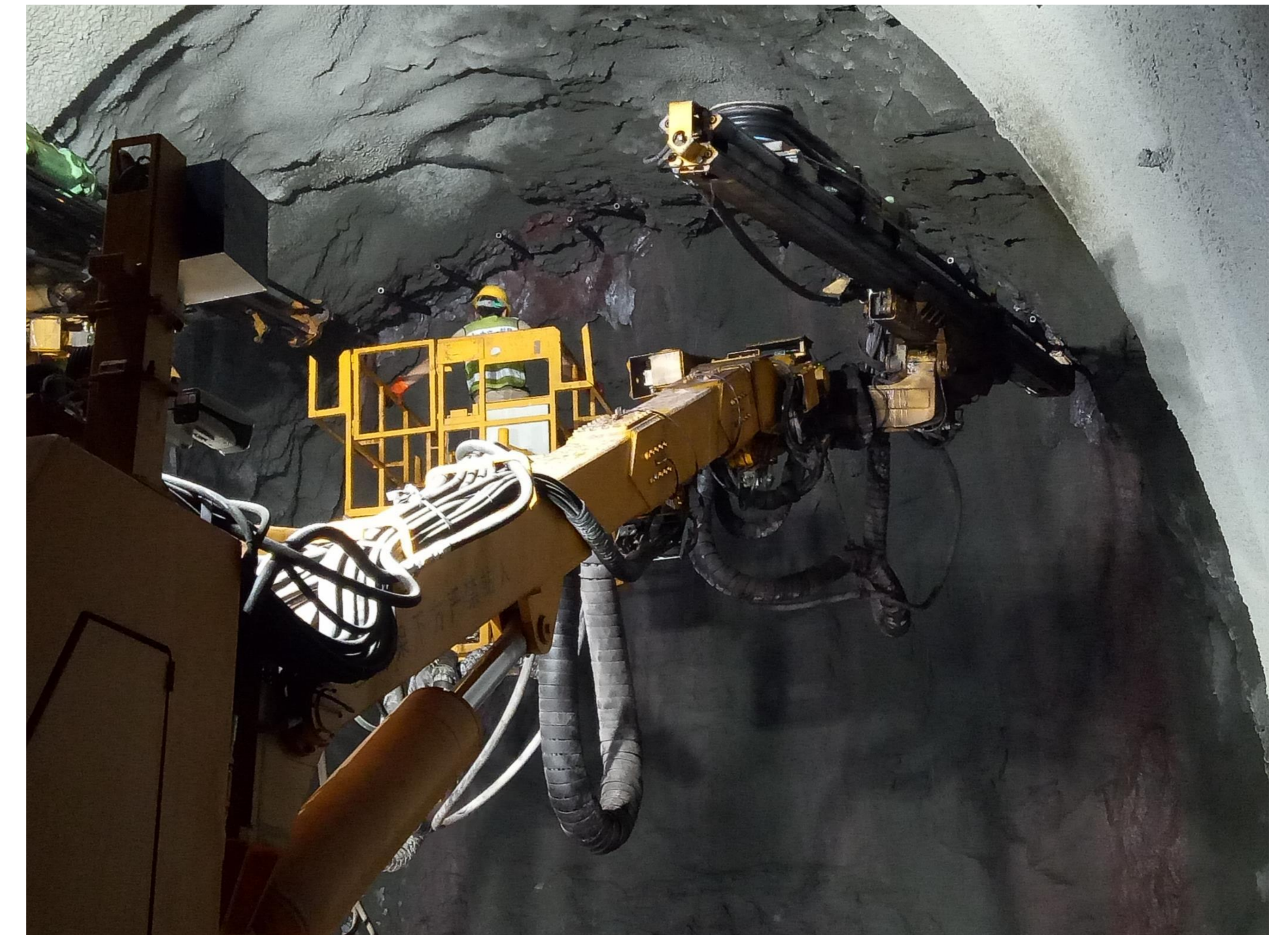
云南西双版纳玉墨铁路曼木树隧道管棚支护
