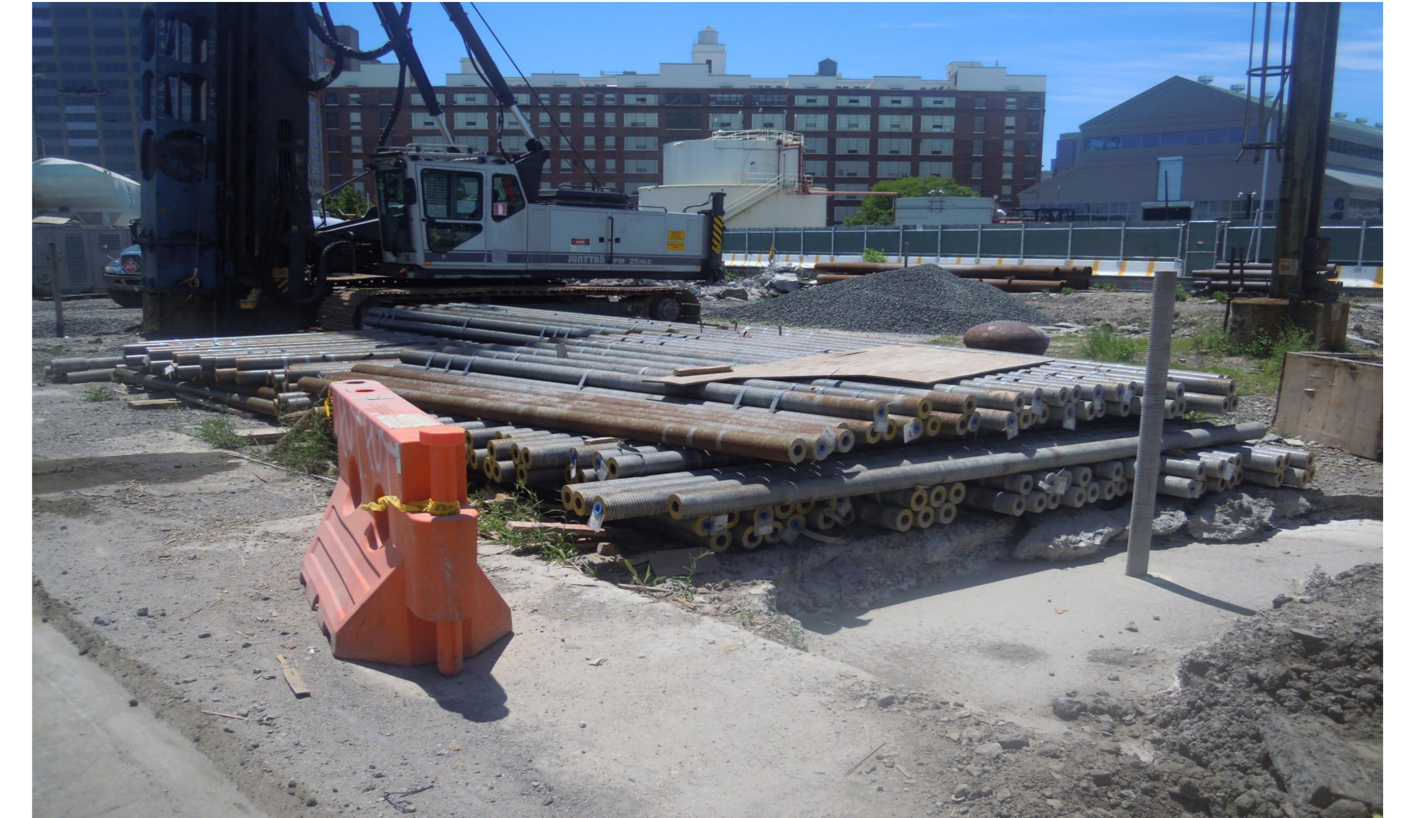
美国纽约布鲁克林造船厂观光塔项目桩基
