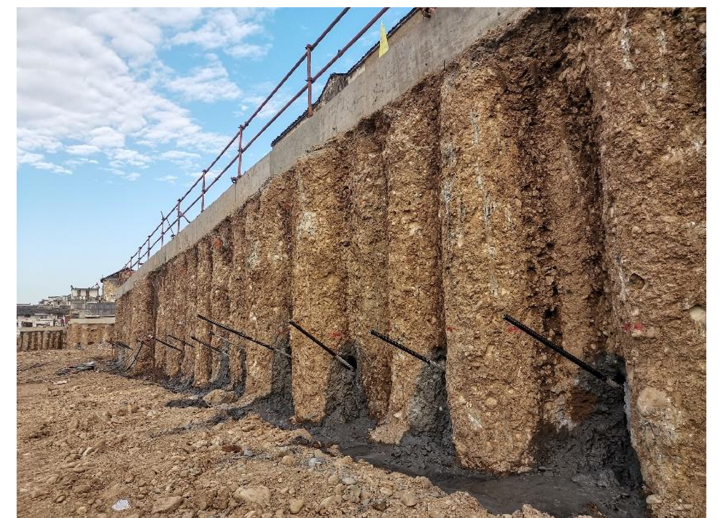
安徽黄山滨江西路步行街基坑支护
