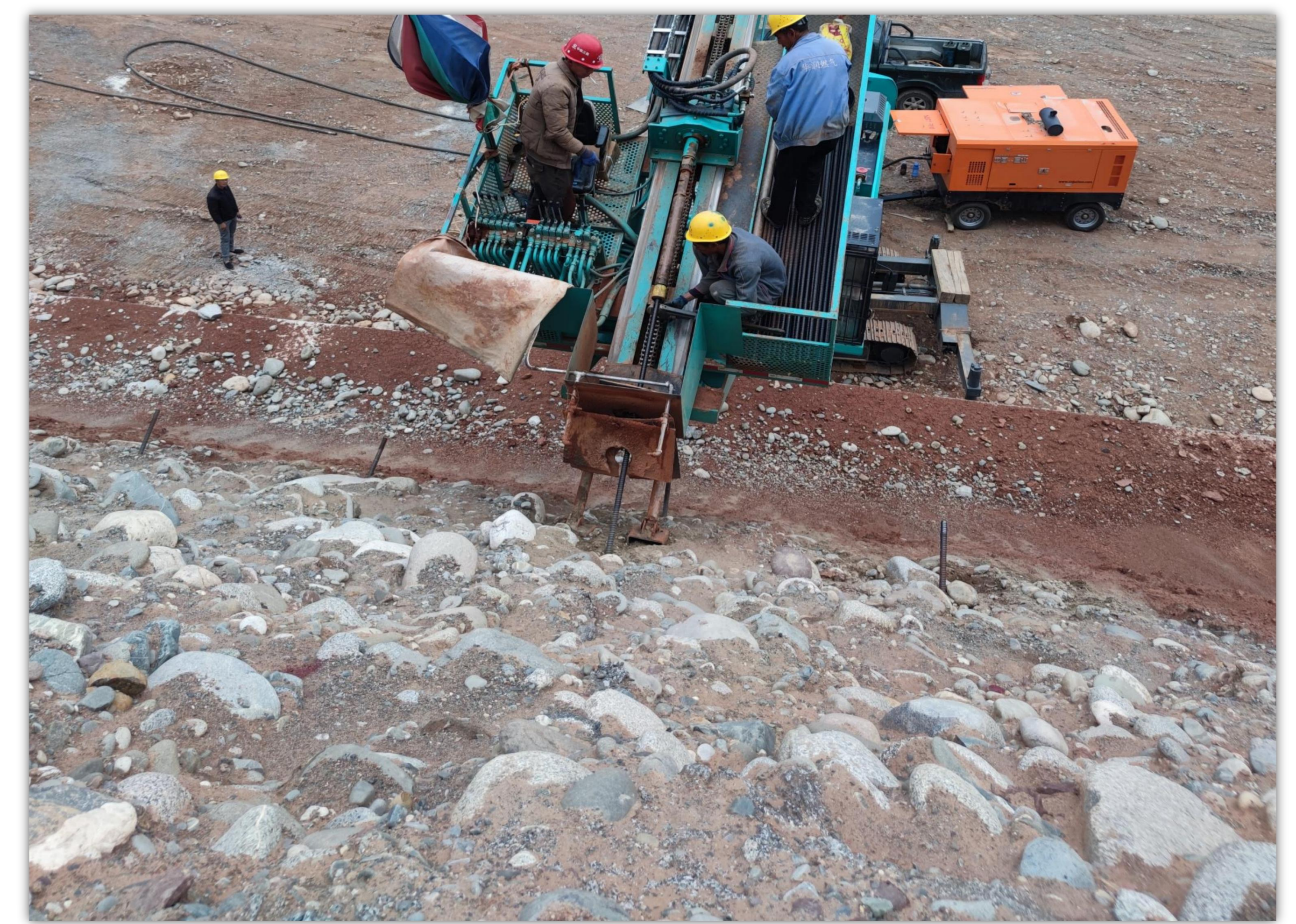
甘肃兰州高速公路边坡支护
