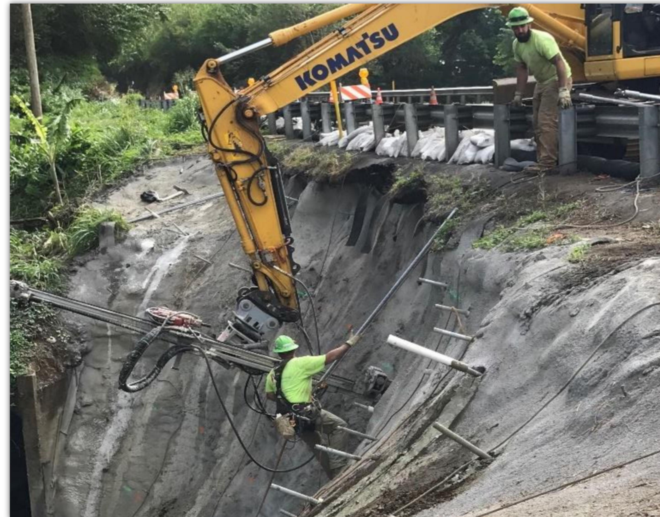
美国夏威夷高速公路边坡支护
