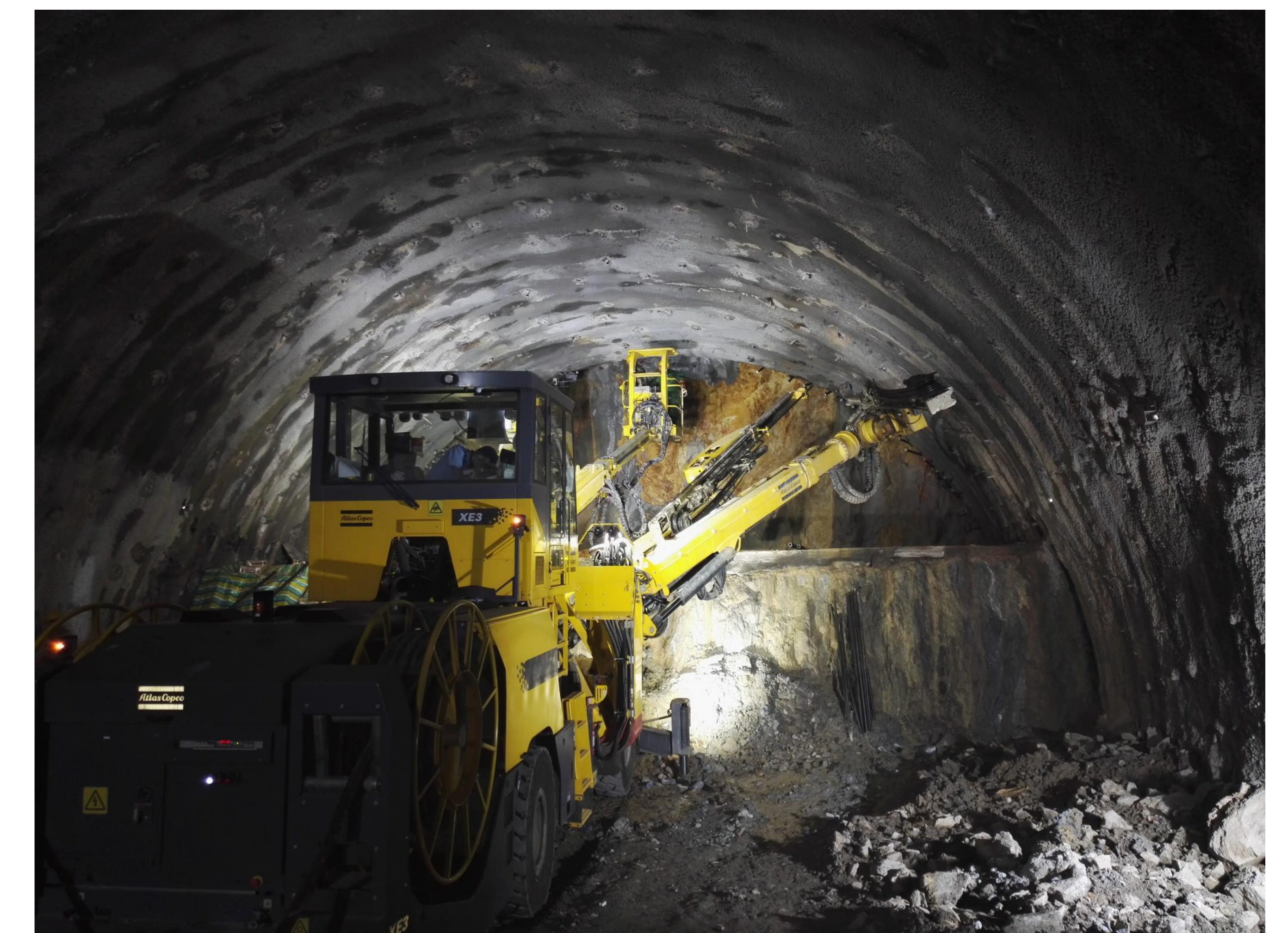
湖北襄阳郑万高铁杏桥坪隧道管棚支护
