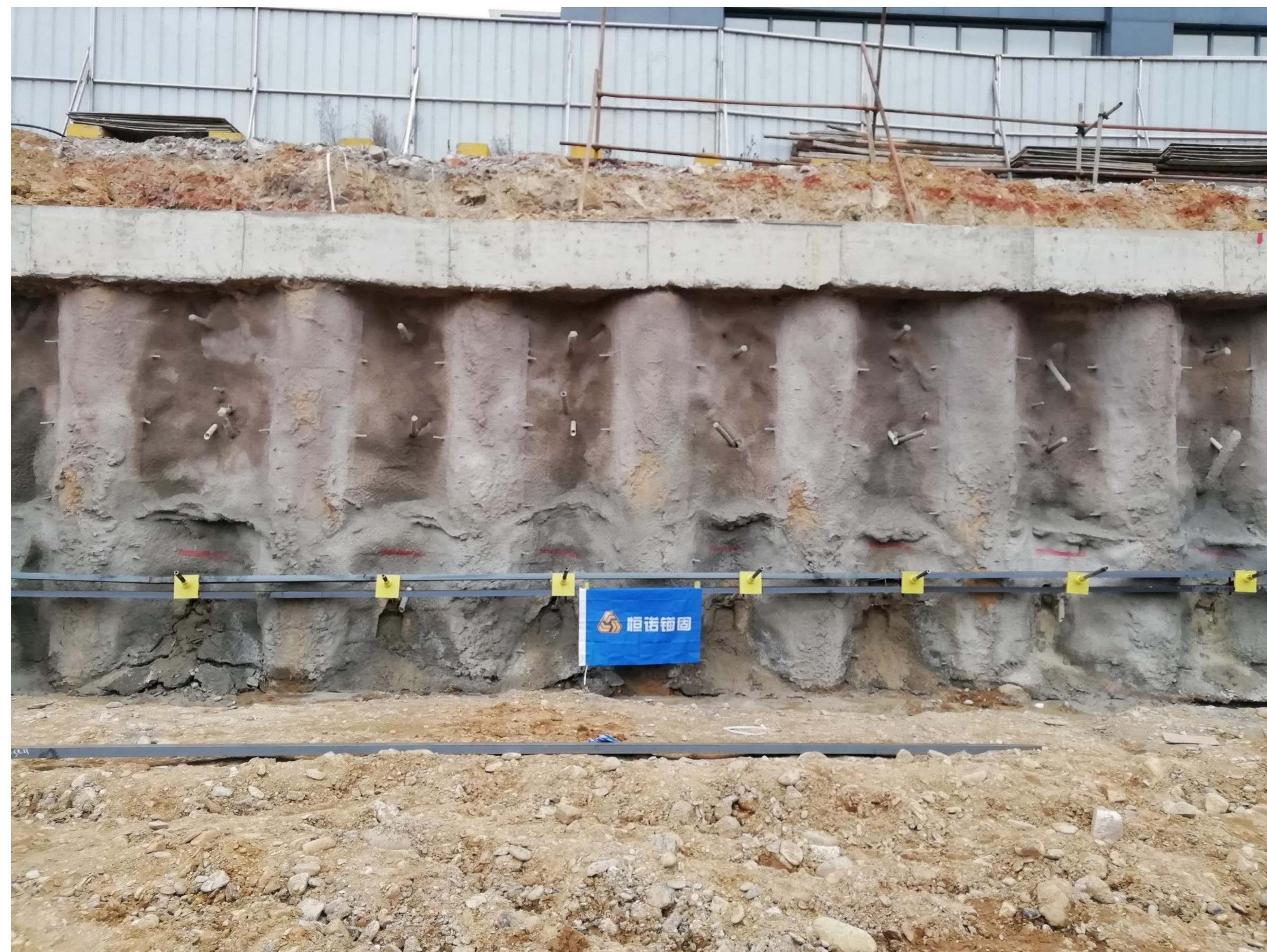
安徽黄山中合农产品市场综合楼基坑支护
