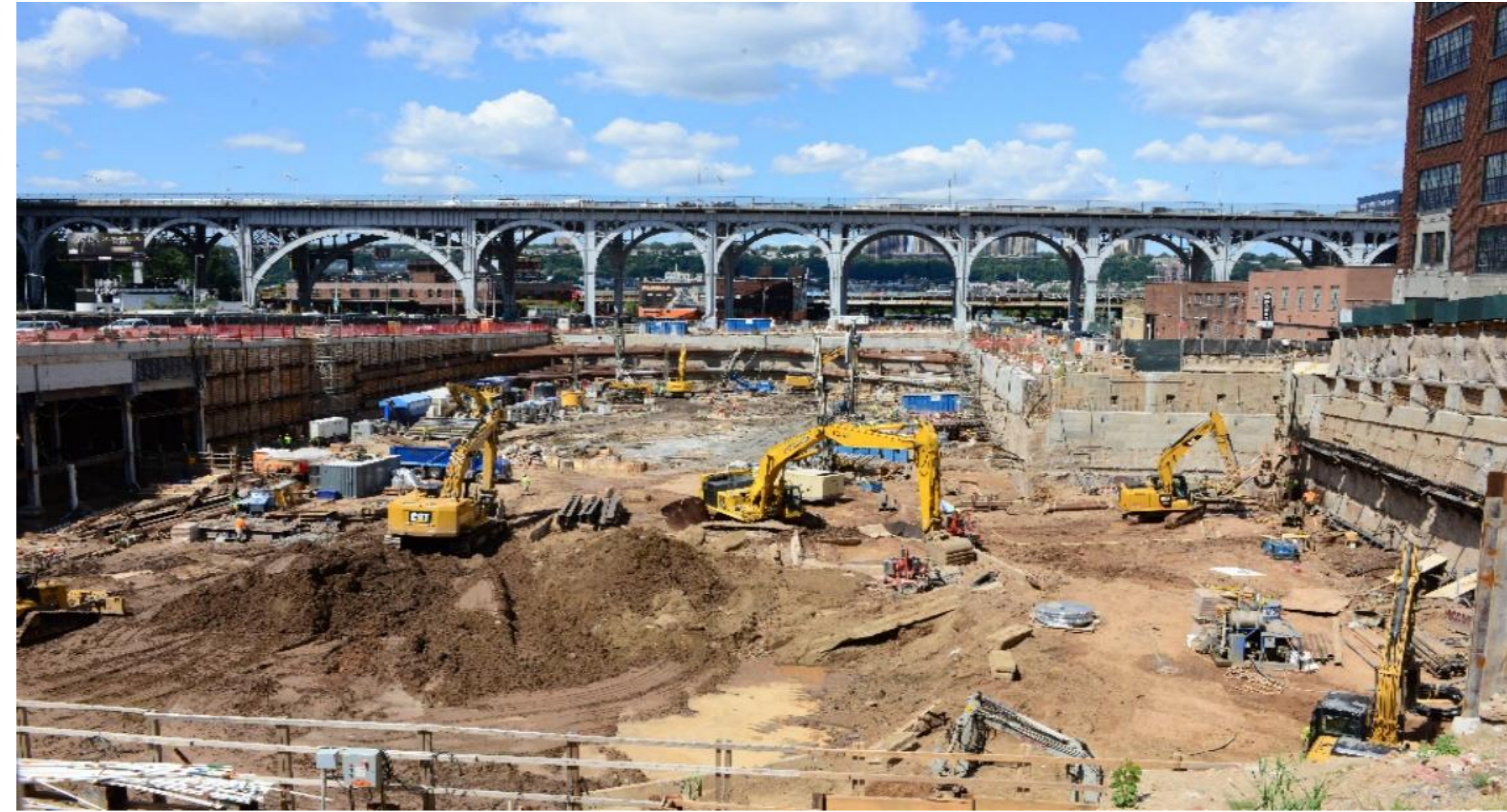
美国哥伦比亚大学项目桩基
