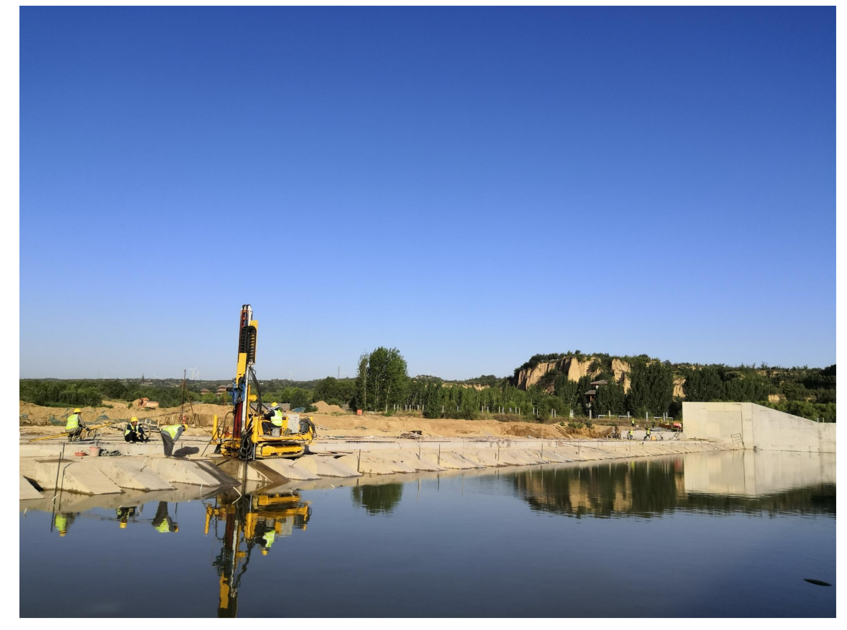
河南三门峡液压坝基础固结灌浆
