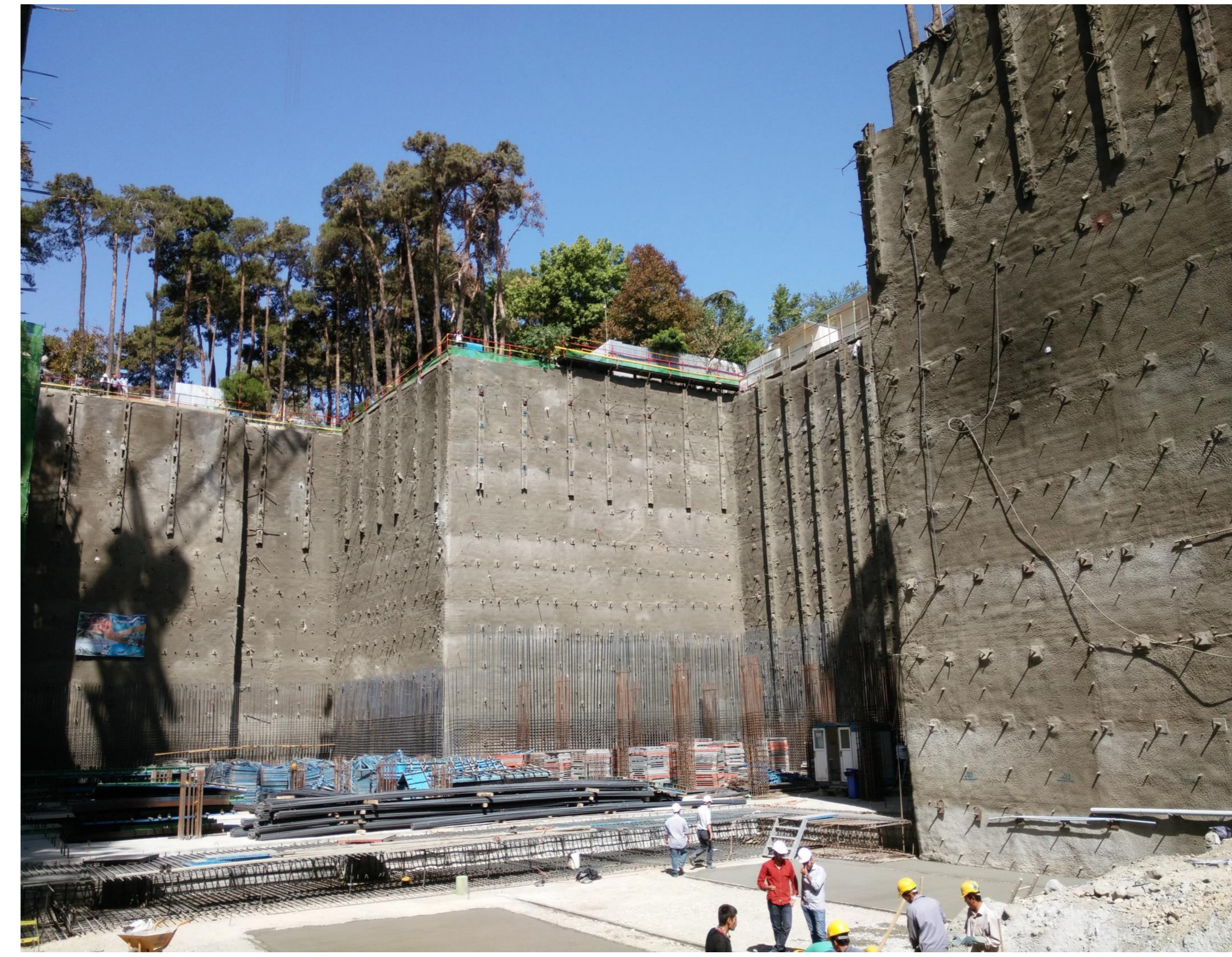
伊朗德黑兰基坑支护
