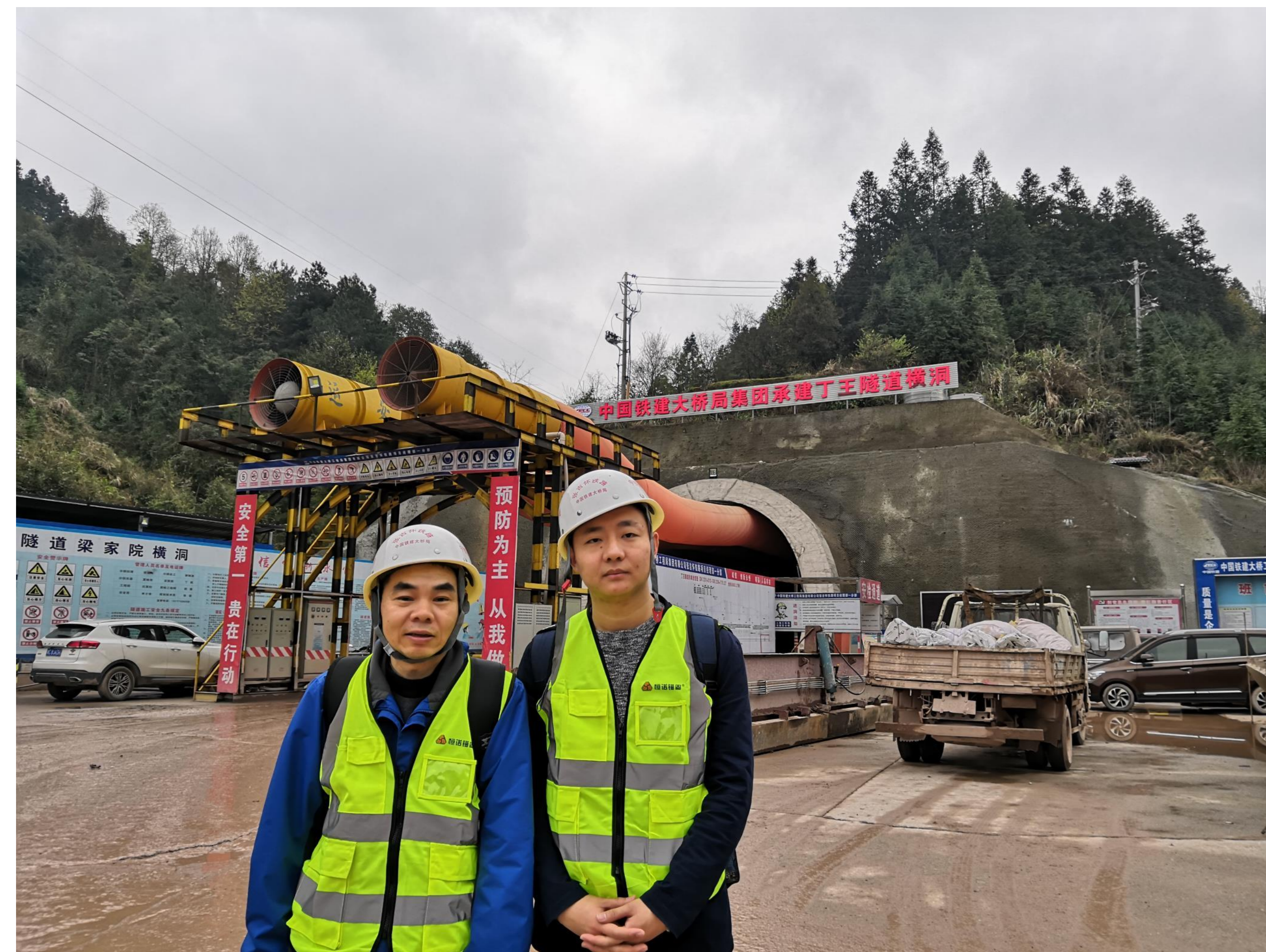
湖南怀化张吉怀铁路丁王隧道管棚支护
