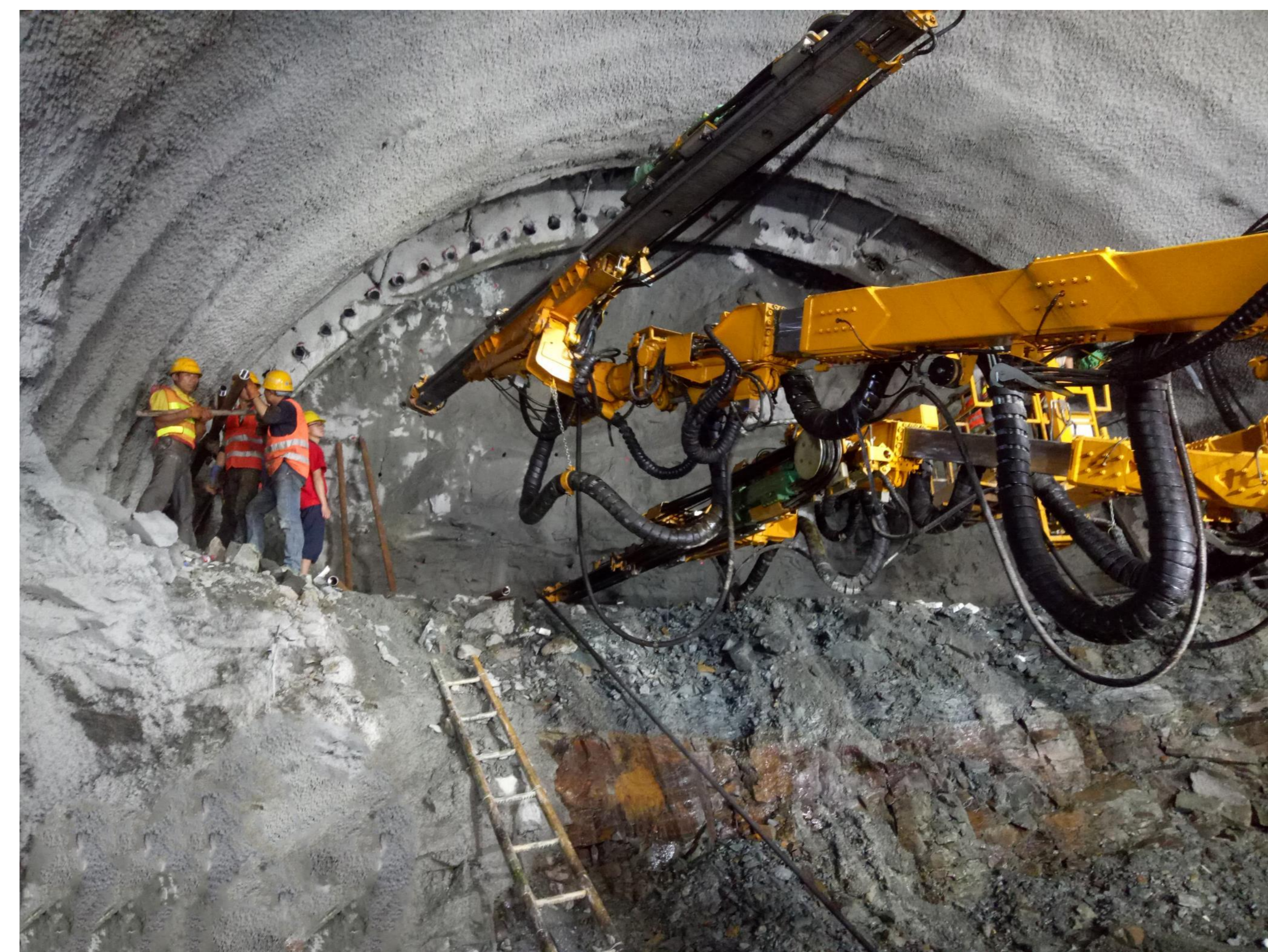
湖北宜昌郑万高铁向家湾隧道管棚支护
