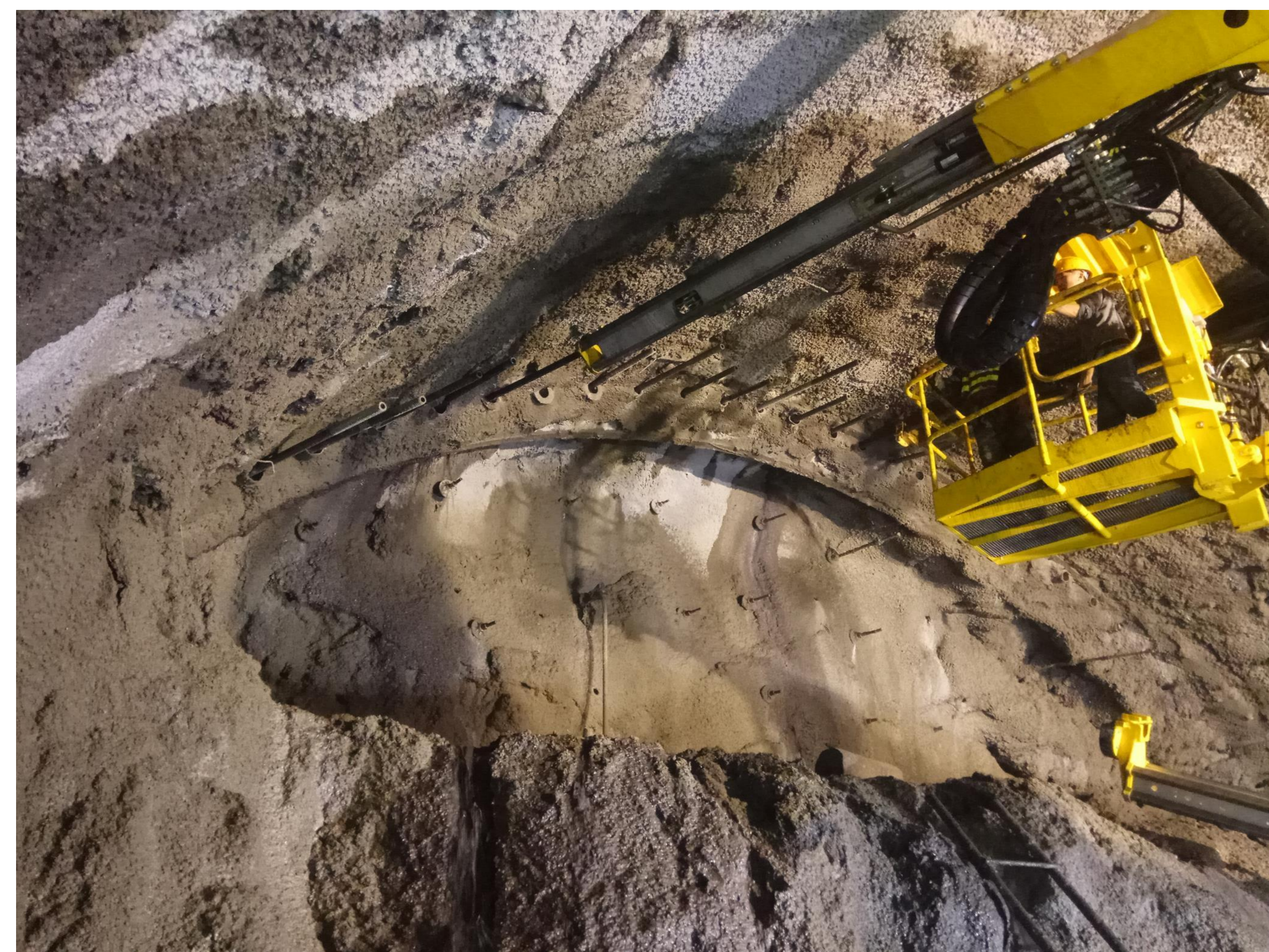
湖北恩施郑万高铁巴东隧道管棚支护
