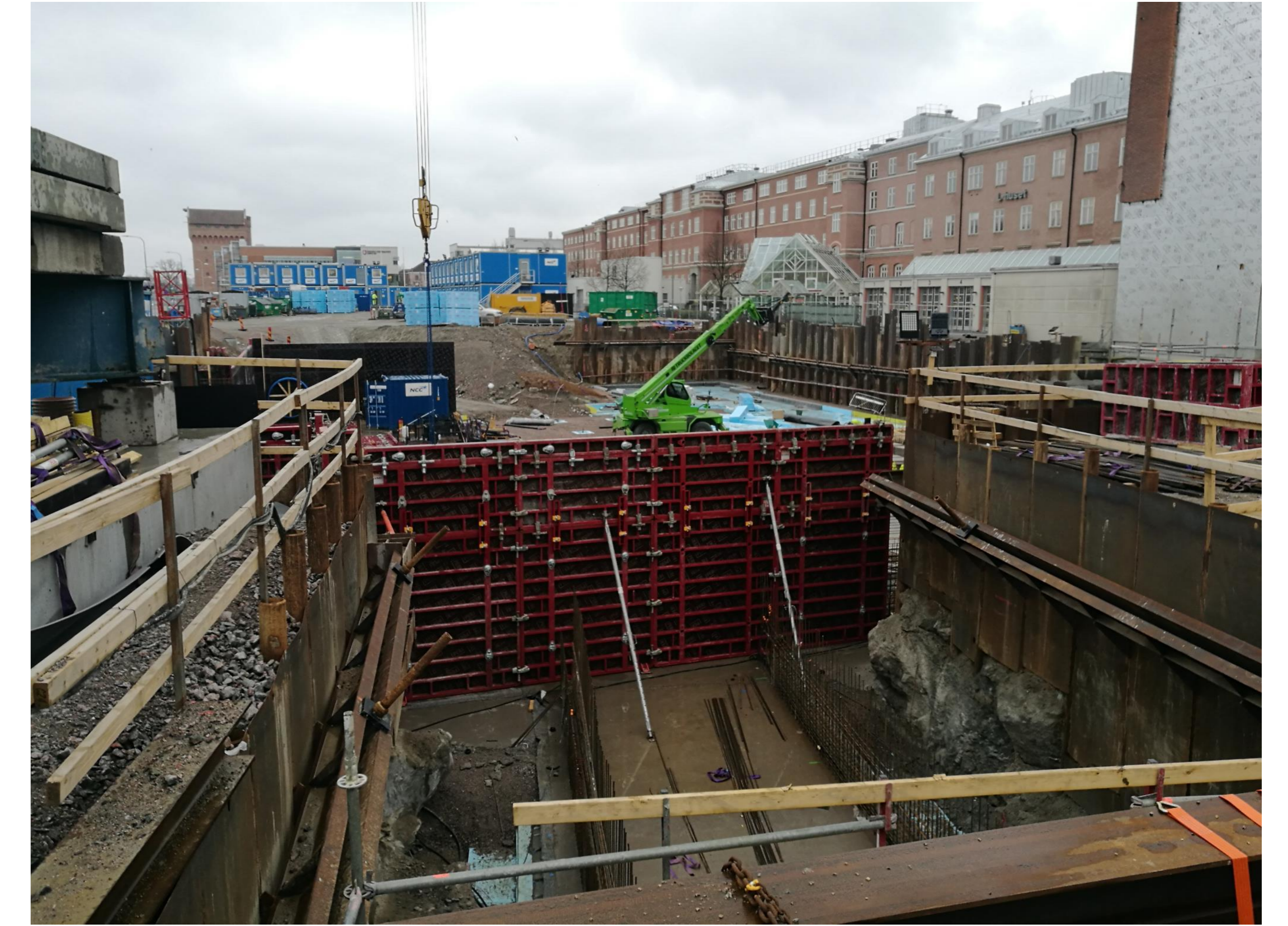
瑞典医院项目基坑支护
