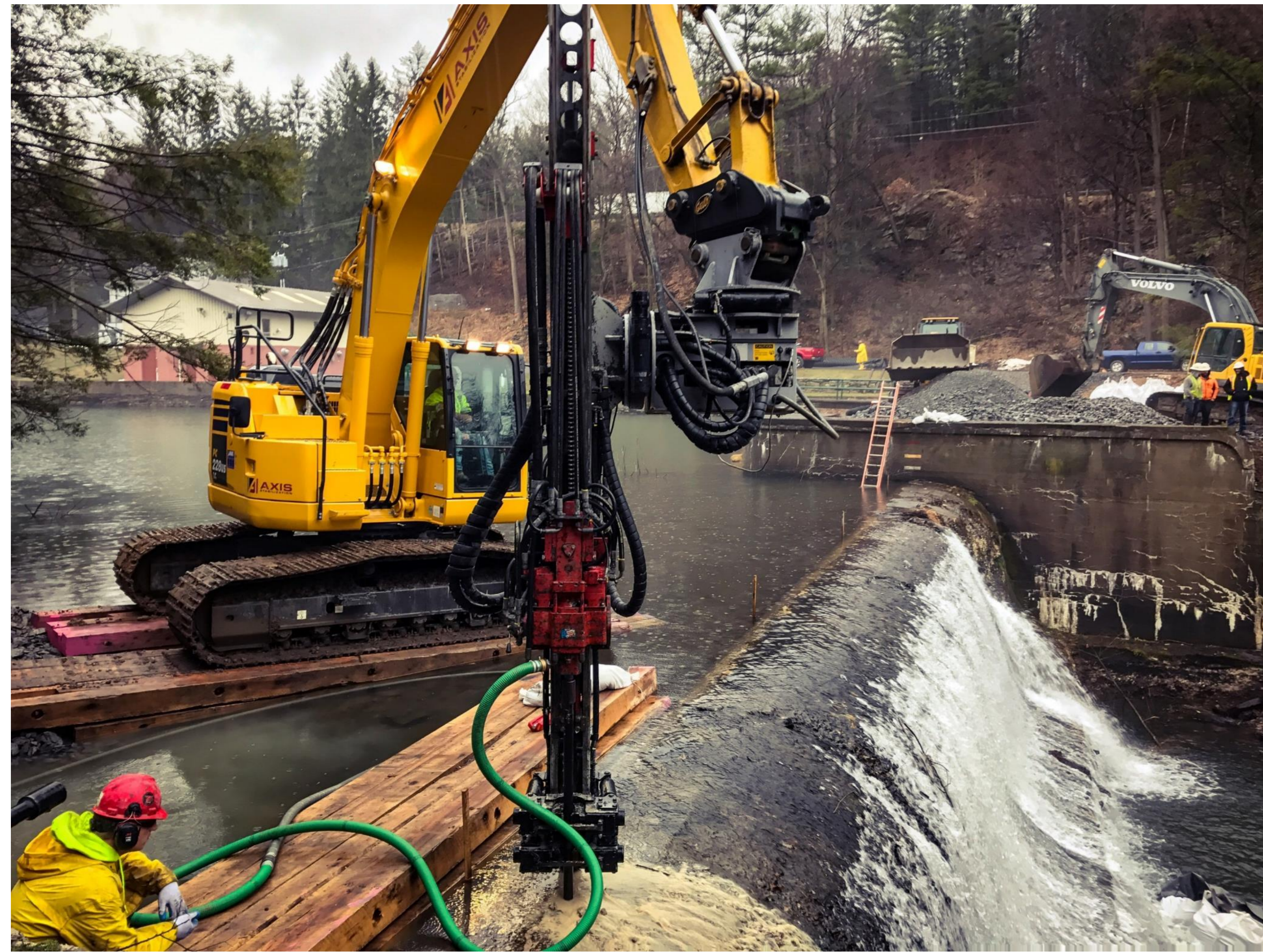
美国阿什维尔坝体桩基
