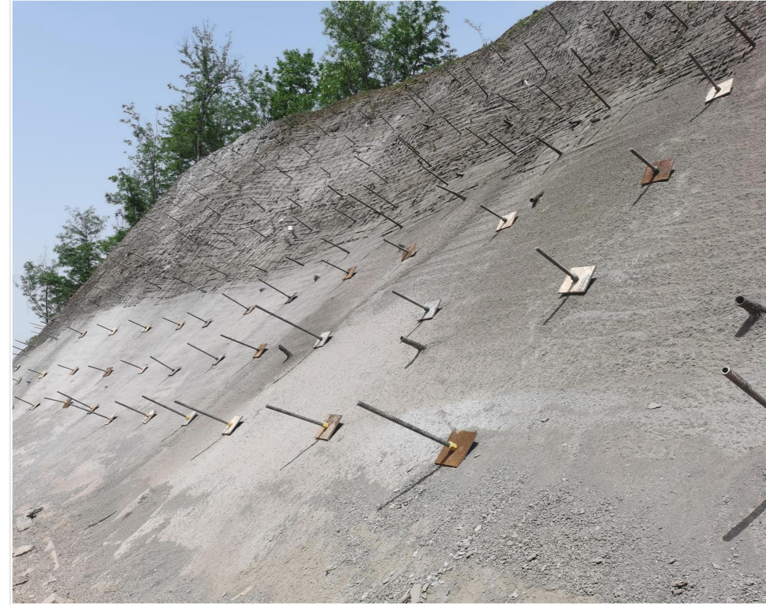
河南洛阳万安山疗养医院边坡支护
