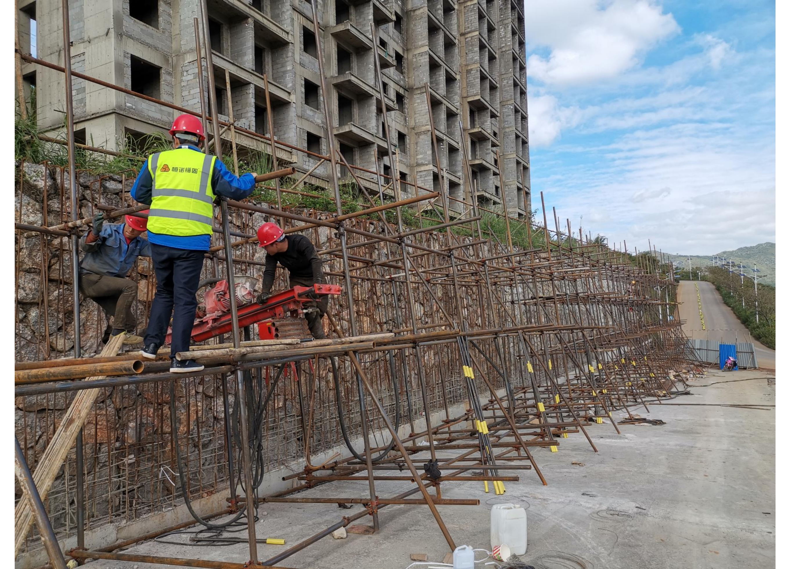
贵州兴义民族师范学院挡土墙加固
