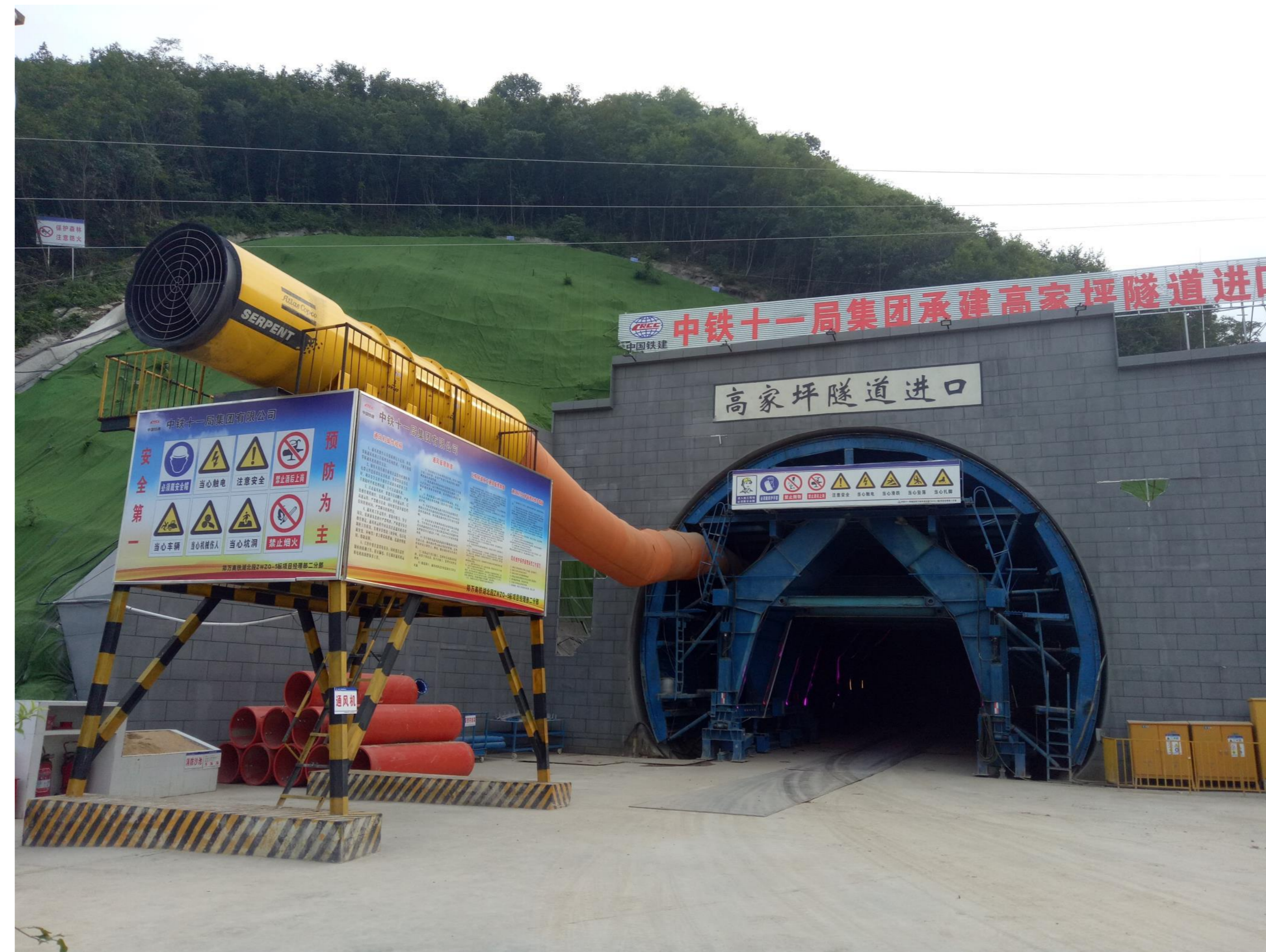
湖北宜昌郑万高铁高家坪隧道管棚支护
