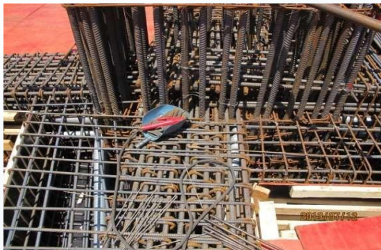
HRB400绑扎现场
