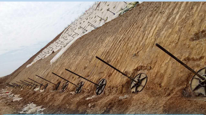
伞型锚加固后
