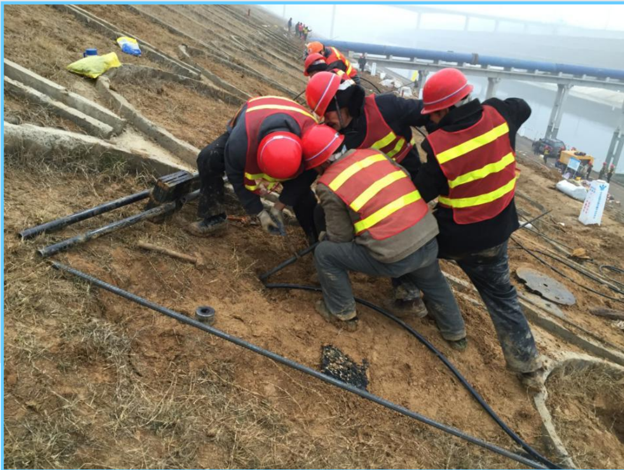
伞型锚人工安装
