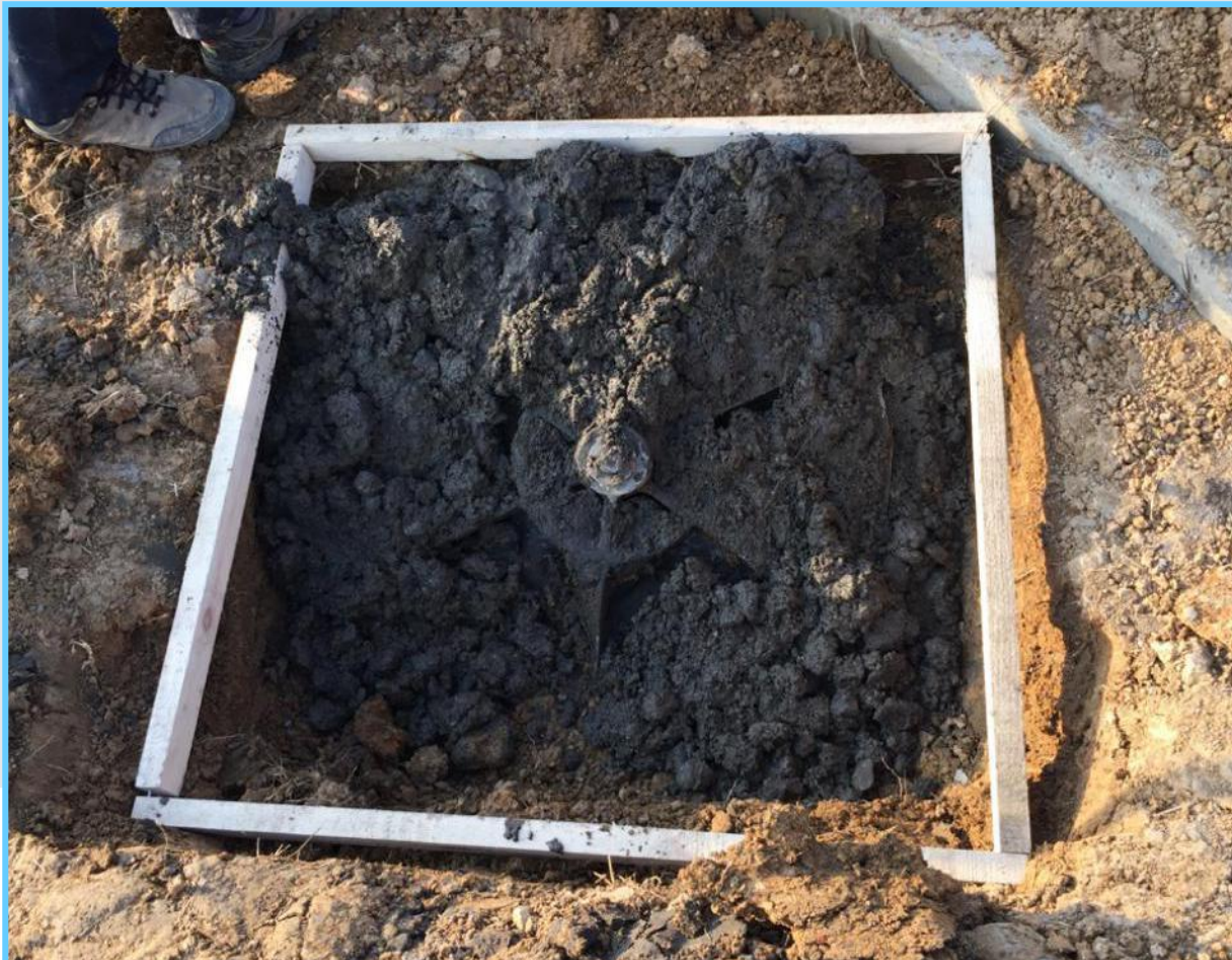
素混凝土封顶保护
