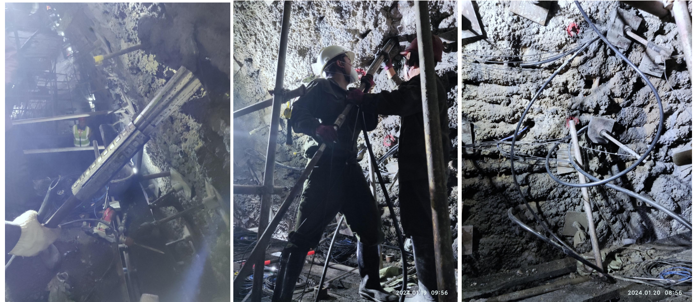
岩体伞型锚加固安装过程
