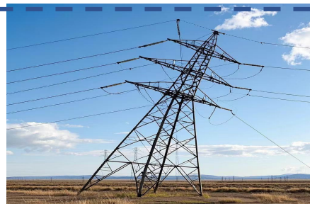
输变电塔倾斜
