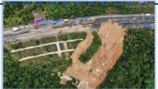
梅大高速路基滑坡
