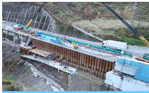
挡墙加固滑坡
