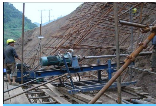
注浆锚杆加固
